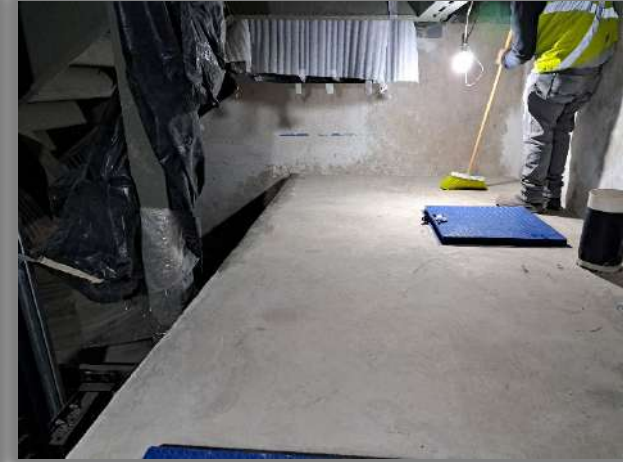
LIMPIEZA FINA PARA ENTREGA DE OBRA
