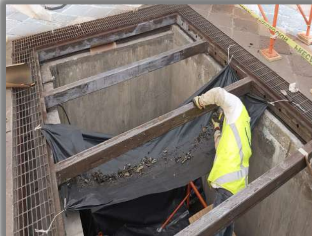
LIBERACION PINTURA ESTRUCTURA METALICA
