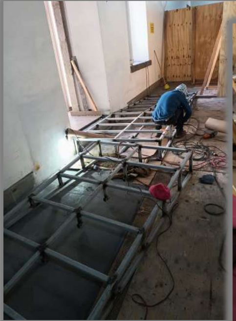
HABILITADO Y ARMADO DE ESTRUCTURA DE PTR PARA RAMPA
