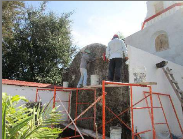
AREA: FACHADA NORTE
