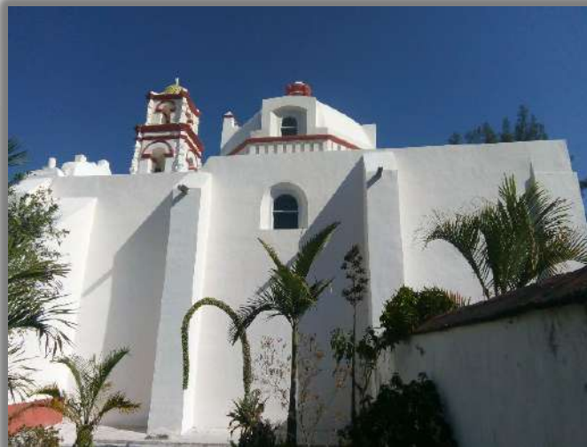
AREA: FACHADA SUR
