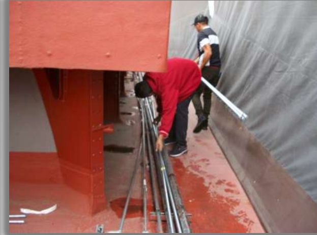
COLOCACIÓN DE TUBERIA CONDUIT DE 3/4" Y 1"
