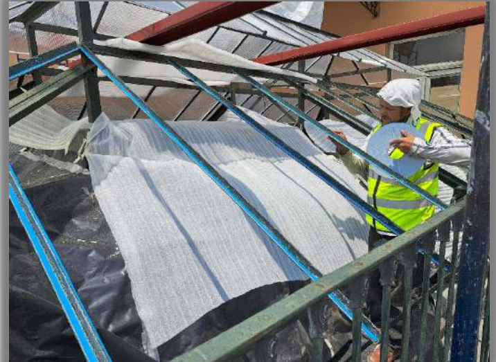
COLOCACION DE CINTA NORTON PARA RECIBIR PLACAS DE POLICARBONATO
