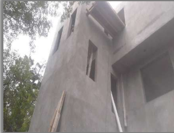
FACHADA CUBO DE ESCALERA
