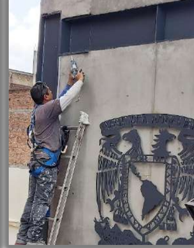
SELLO POLIURETANO EN ESTRUCTURA
