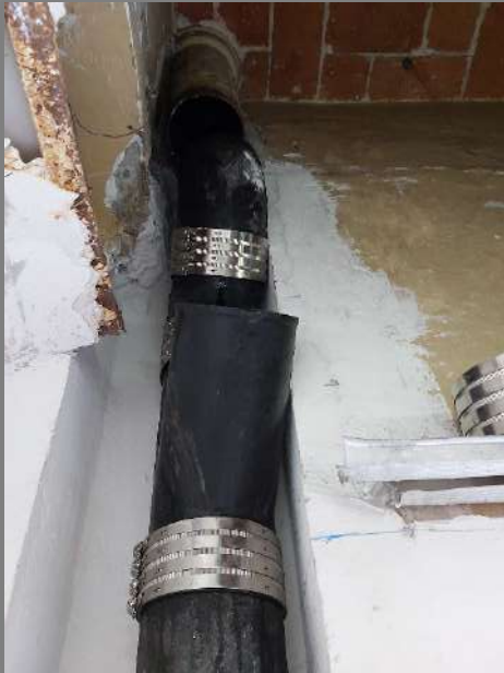
REINTEGRACION DE TUBERÍA DE FOFO
