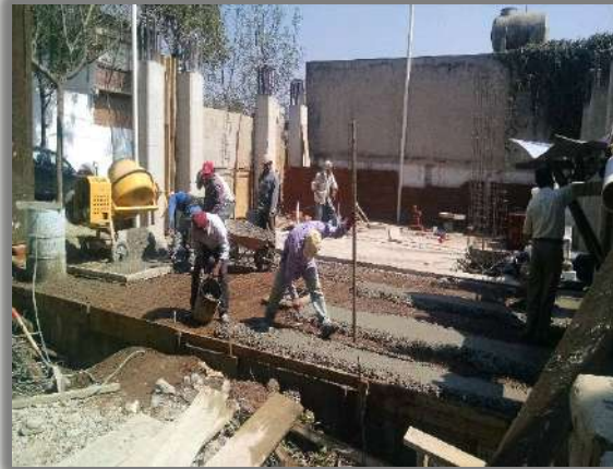
CONTRATRABE Y LOSA NIVEL SOTANO
