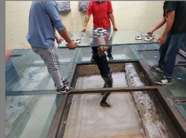
DESMONTAJE DE CRISTALES TEMPLADOS
