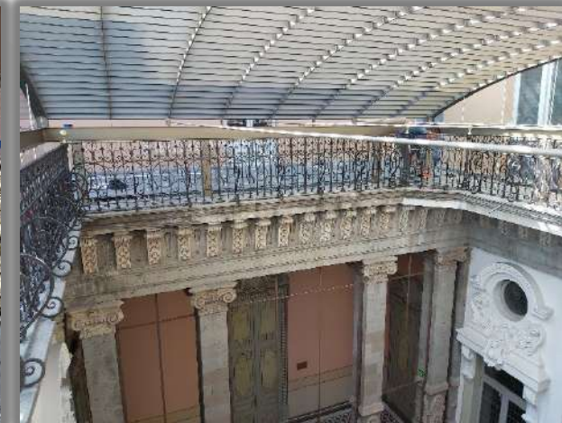
VISTA GENERAL INTERIOR DE DOMO
