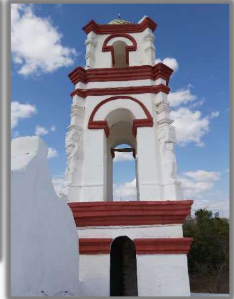
AREA: TORRE CAMPANARIO
