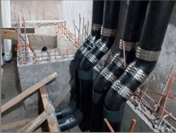
INTEGRACIÓN DE TUBERIA Y CONEXIONES DE FOFO DE 6"
