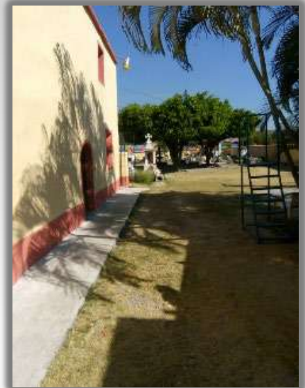
AREA: FACHADA SUR
