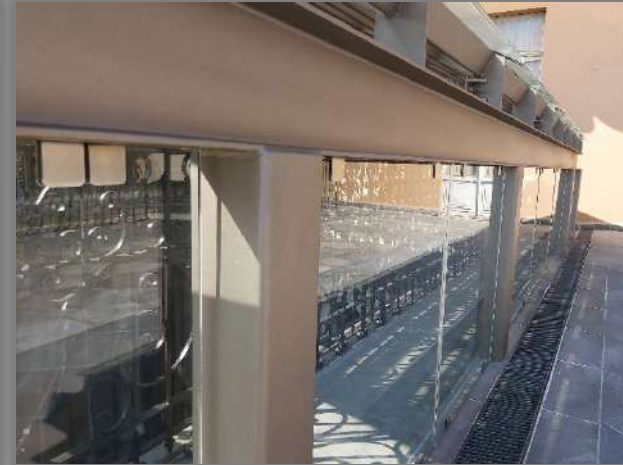
VISTA FACHADA PONIENTE
