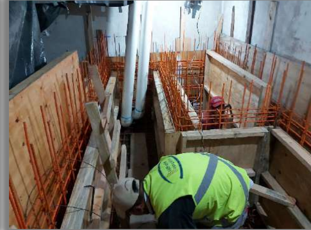
HABILITADO Y COLOCACIÓN DE CIMBRA
