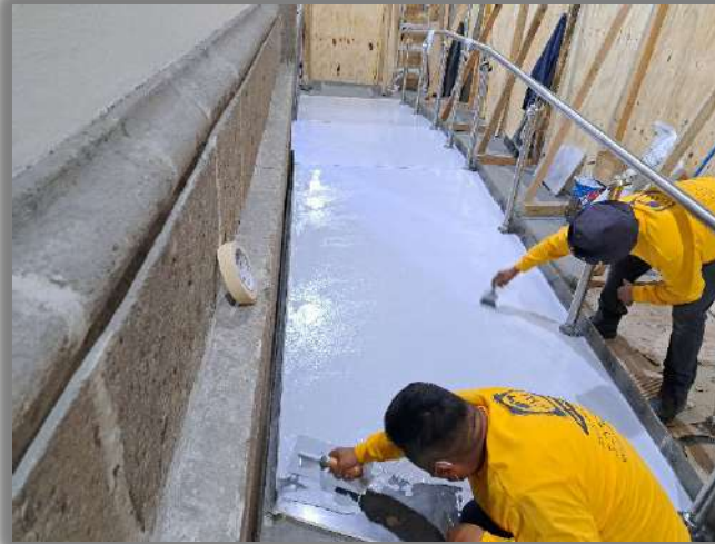
APLICACIÓN DE PRIMARIO EPÓXICO
