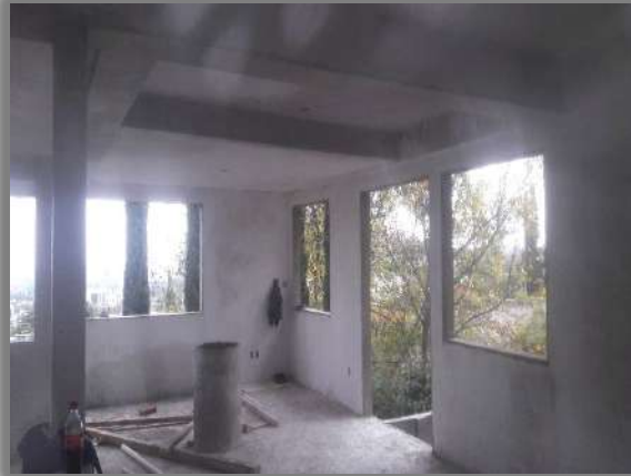
APLANADO DE MUROS
