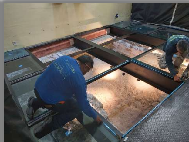
COLOCACION DE CRISTALES
