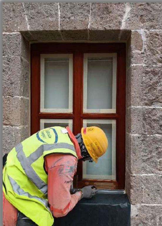
APLICACIÓN DE ACABADO POLIFORM NOGA Y CERA EN VENTANAS Y PUERTA DE MADERA
