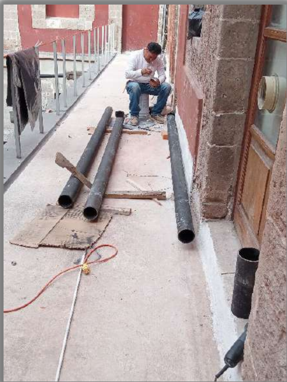
COLOCACION DE TUBERIA DE FO FO PARA BAJADAS DE AGUA PLUVIAL EN PLANTA ALTA Y PLANTA BAJA DE FACHADA DE TERRAZA
