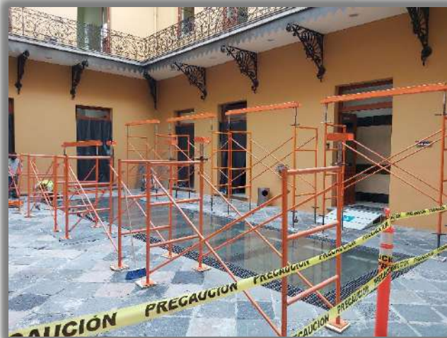
ARMADO DE CARPA PARA PROTECCION
