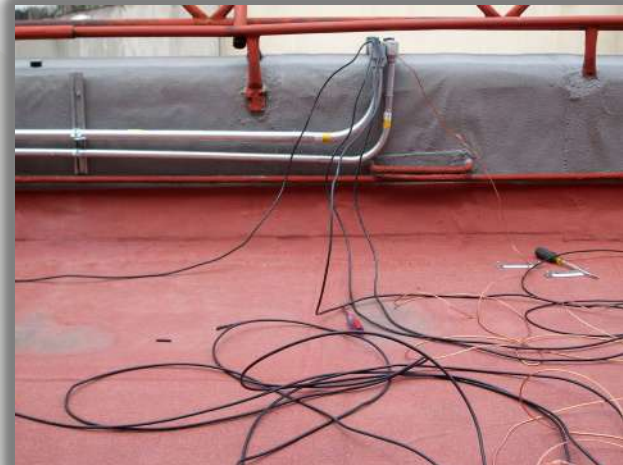
ALIMENTACION DE CABLE CAL. 8, 10 Y DESNUDO
