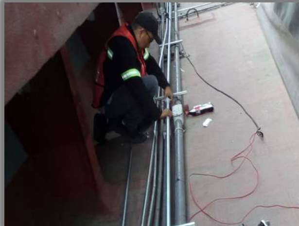
CONECTORES PARA TUBERIA CONDUIT DE 3/4" Y 1"
