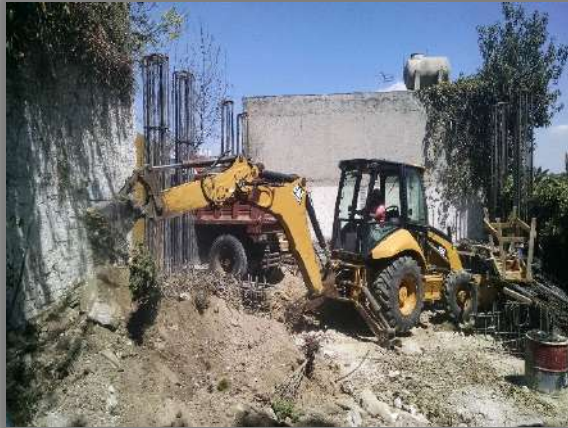
EXCAVACION PARA ABRIR CAJA
