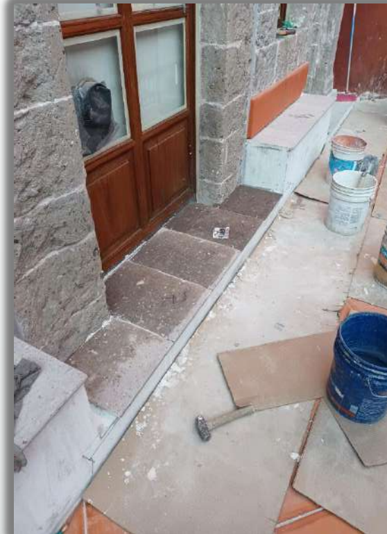
COLOCACION DE CANTERA GRIS EN PISO DE BANO DEPUERTA DE ACCESO
