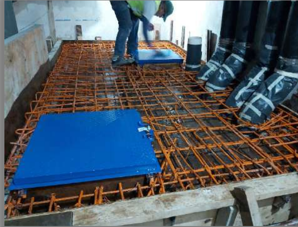
HABILITADO Y ARMADO ACERO DE LOSA TAPA DE CÁRCAMO Y COLOCACIÓN DE TAPAS DE REGISTRO
