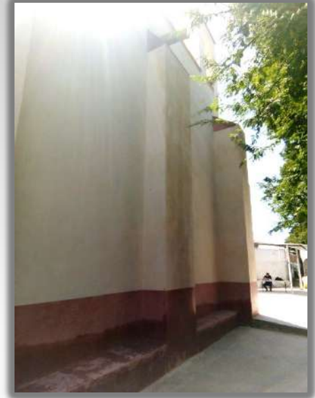
AREA: FACHADA LATERAL PONIENTE
