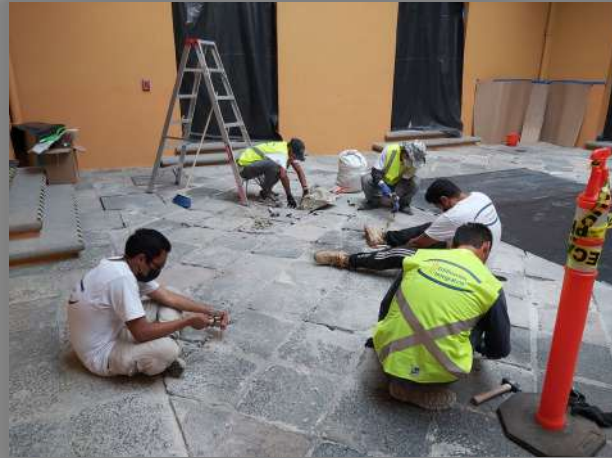
LIBERACION DE JUNTAS EN PISO DE RECINTO
