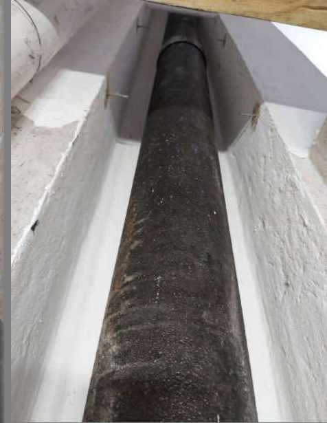
FABRICACION DE TRINCHERA Y REINTEGRACION DE TUBERIA DE FOFO
