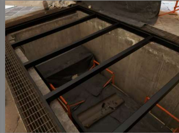
APLICACIÓN DE PINTURA ESTRUCTURA METALICA
