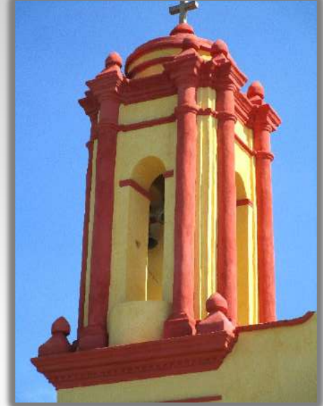
AREA: TORRE CAMPANARIO IZQUIERDA
