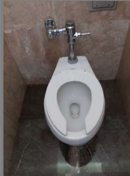
COLOCACION DE ACCESORIOS Y MUEBLES SANITARIOS
