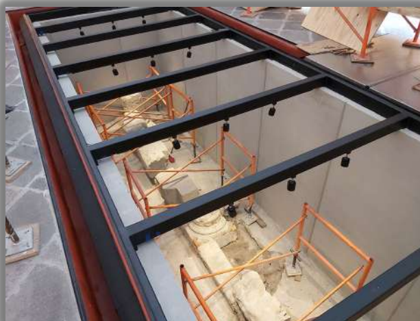
COLOCACION DE LUMINARIAS
