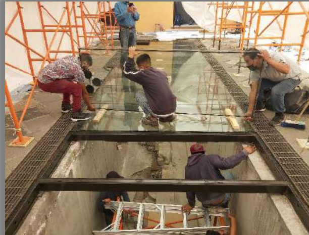
DESMONTAJE DE CRISTALES TEMPLADOS
