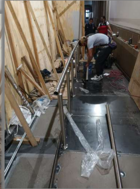
HABILITADO Y ARMADO DE BARANDAL DE ACERO INOXIDABLE
