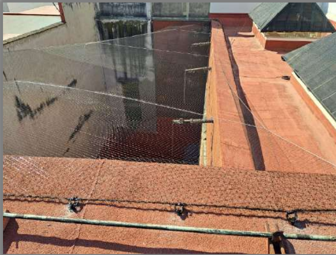
COLOCACION DE MALLA ANTIAVES EN PATIO EXTERIOR
