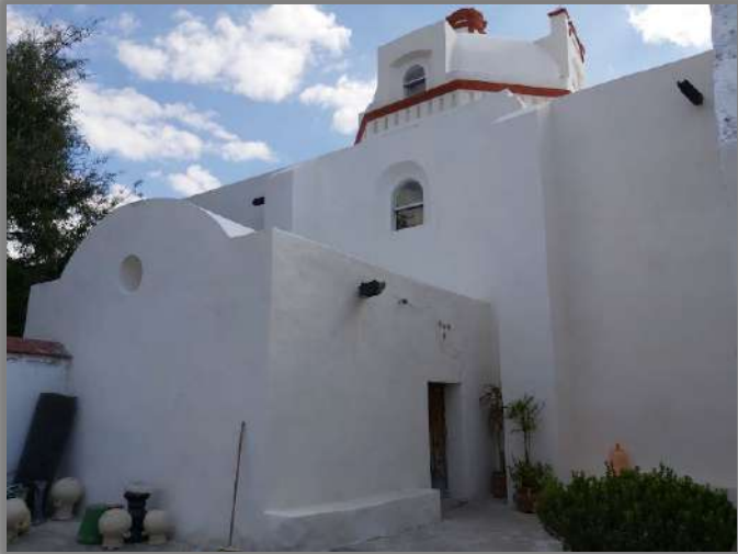
AREA: FACHADA NORTE
