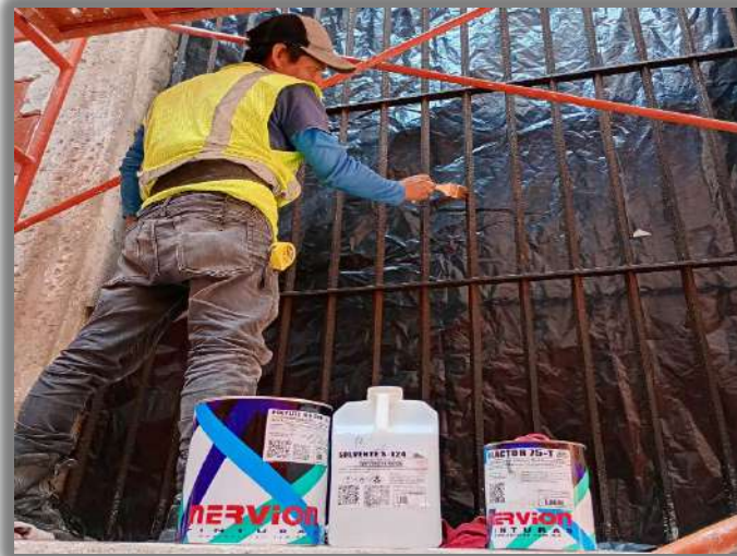
FABRICACION DE PUERTA METALICA A BASE DE PERFILES PTR, CUADRADO Y LAMINA
