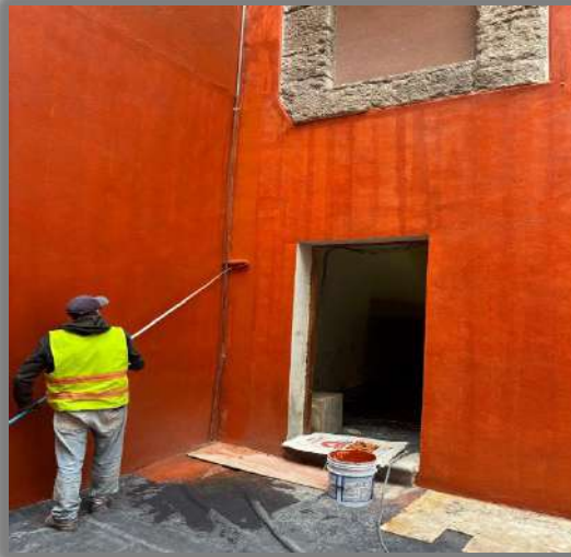
APLICACIÓN DE PINTURA EN MUROS DE PATIO EXTERIOR
