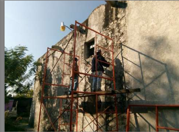
AREA: FACHADA SUR)
