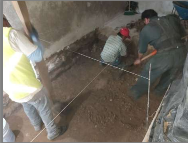
EXCAVACIÓN, AFINE Y COMPACTACION DE FIRME
