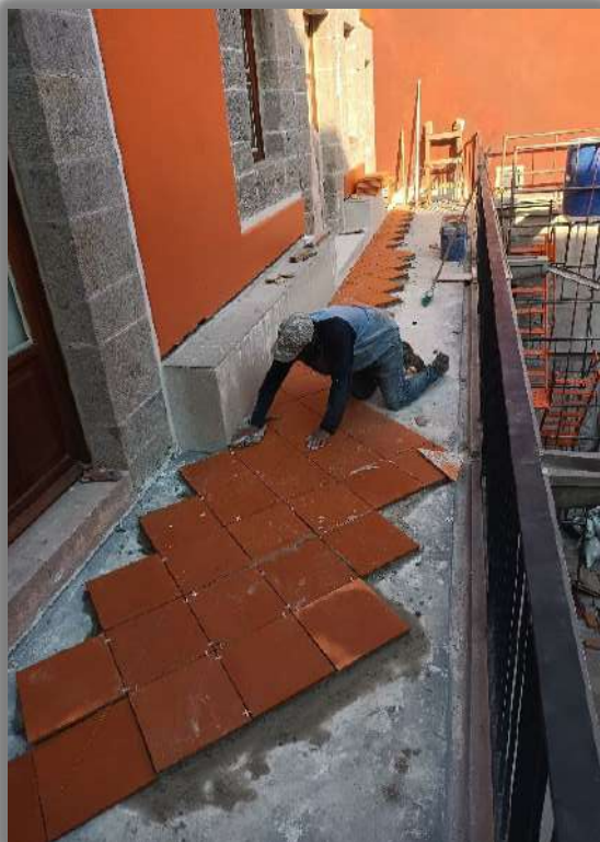
COLOCACION DE BALDOSAS EN PISO DE TERRAZA
