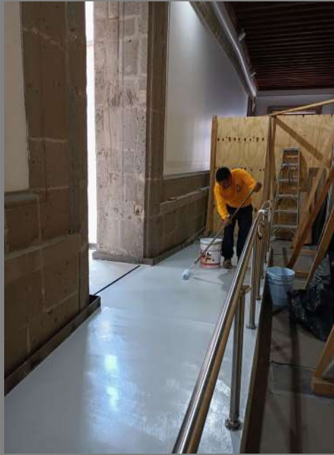
APLICACIÓN DE PRIMARIO EPÓXICO
