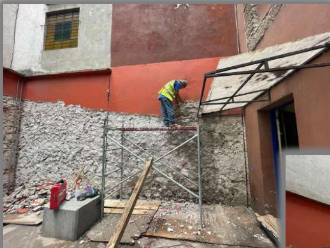
LIBERACION DE APLANADOS EN MUROS EXTERIORES EN PATIO DE BIBLIOTECA
