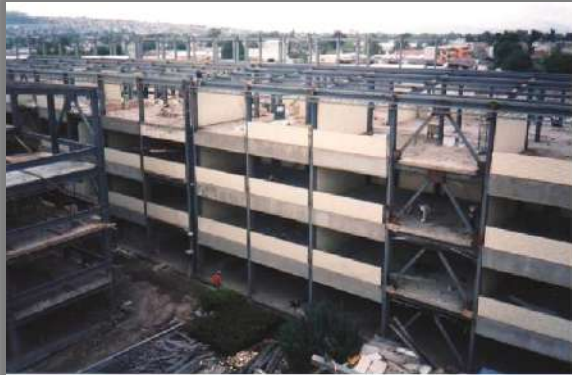
OBRA: EDIFICIO AULAS I
