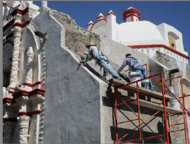
AREA: FACHADA SUR
