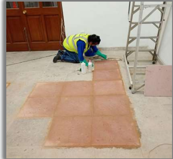
REINTEGRACION DE PISO DE CANTERA ROSA
