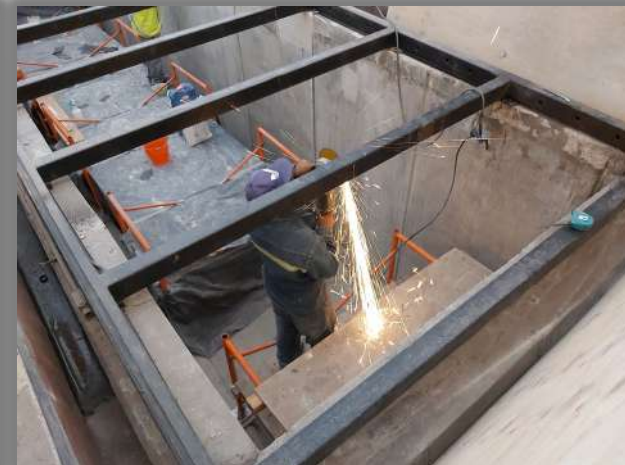
REESTRUCTURACION ESTRUCTURA METALICA
