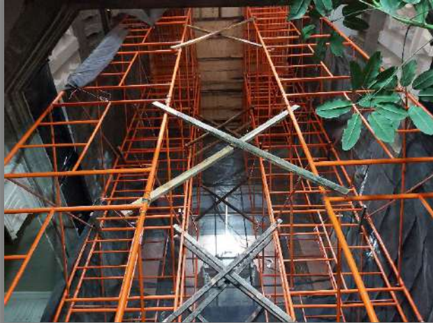
DESPLANTE DE ANDAMIOS EN DOMO PATIO PRINCIPAL
