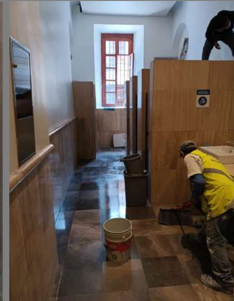
LIMPIEZA FINA PARA ENTREGA DE OBRA
