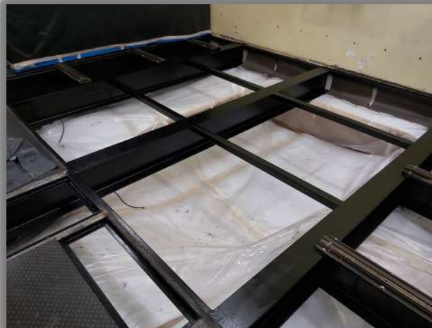
APLICACIÓN DE PINTURA ESTRUCTURA METALICA
