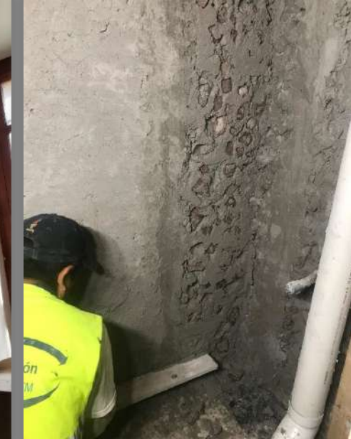
INTEGRACION DE MAMPOSTEO
