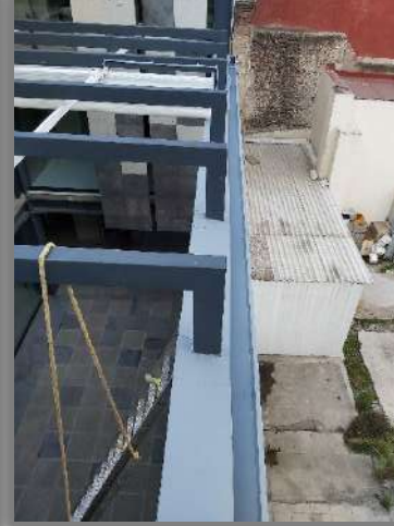
PRIMARIO Y PINTURA EN ESTRUCTURA
