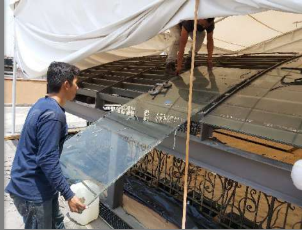
DESMONTAJE DE CRISTALES
