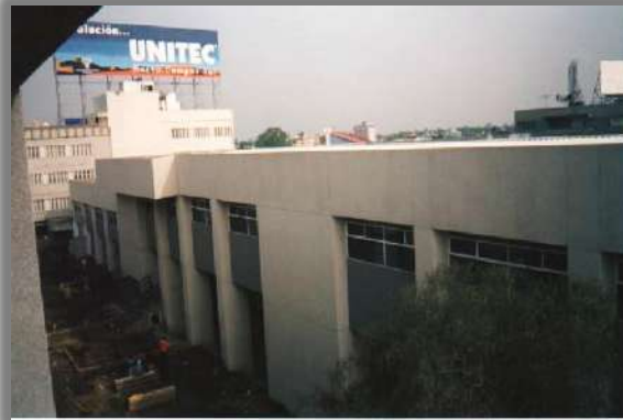
OBRA: EDIFICIO AULAS I
