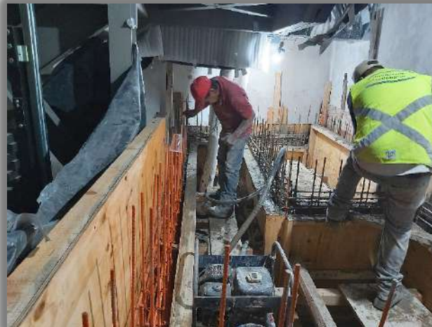
COLADO DE CÁRCAMO
