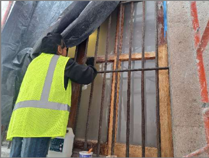
LIBERACION DE ACABADO EN VENTANAS DE MADERA DEL PATIO EXTERIORES
