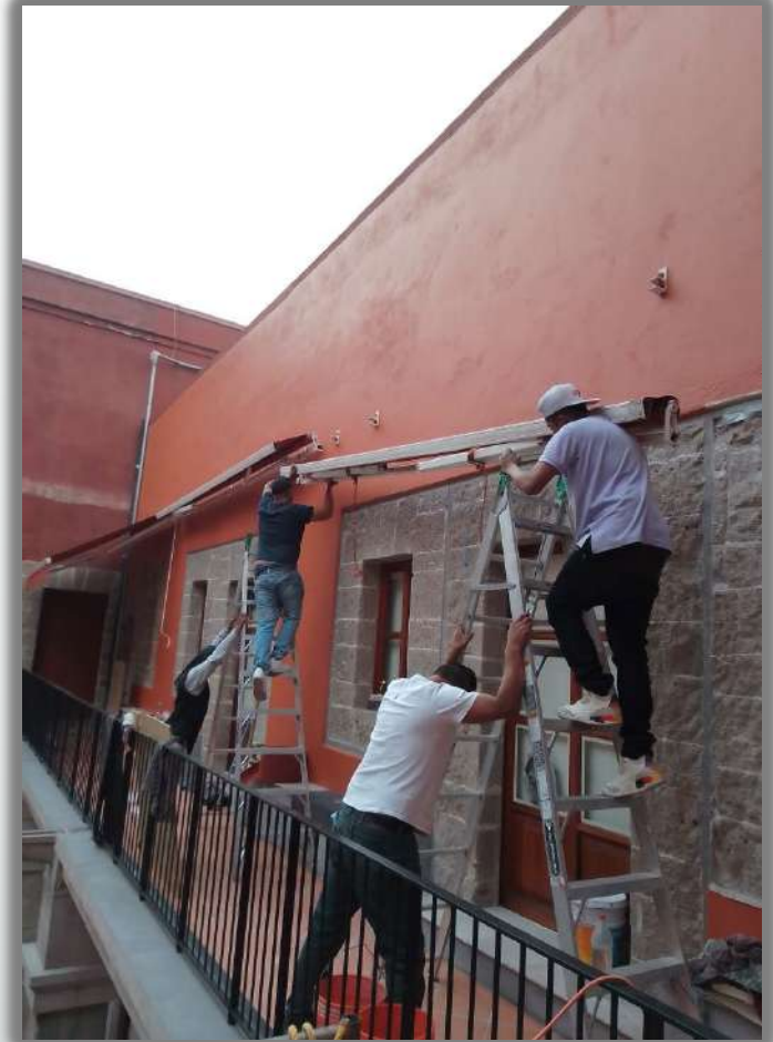
MANTENIMIENTO DE TOLDOS ARTICULADOS EN FACHADA NORTE
