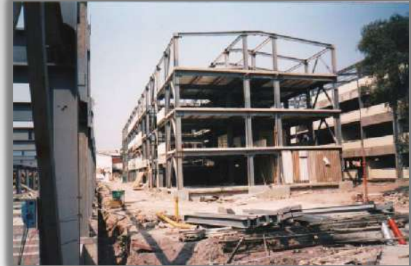
OBRA: EDIFICIO AULAS II
