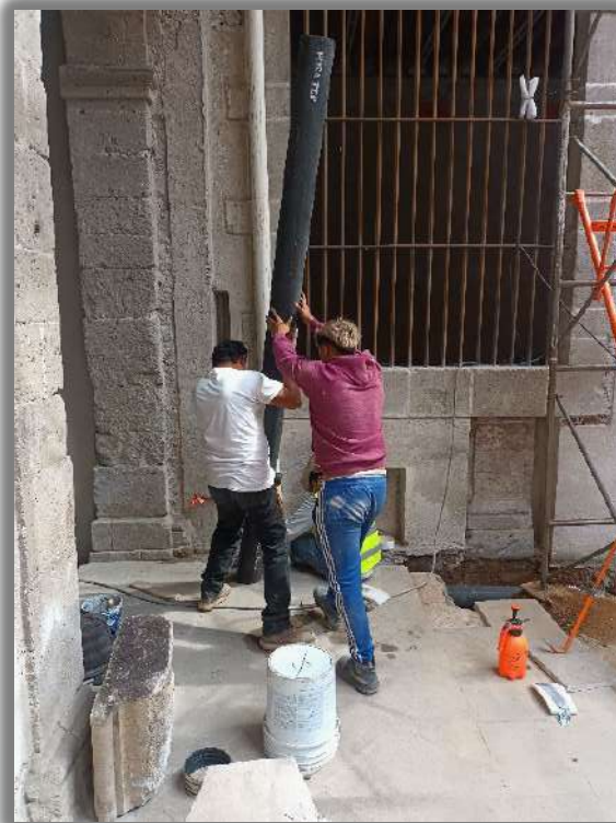
COLOCACION DE TUBERIA DE FO FO PARA BAJADAS DE AGUA PLUVIAL EN PLANTA ALTA Y PLANTA BAJA DE FACHADA DE TERRAZA
