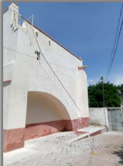
AREA: FACHADA LATERAL ORIENTE
