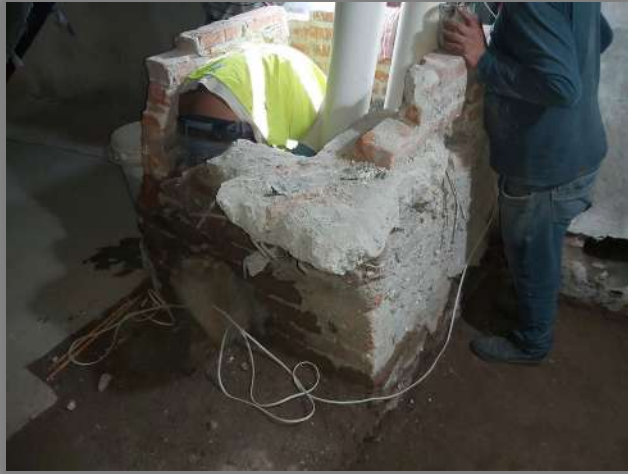
LIBERACIÓN DE MAMPOSTERIA Y TUBERIA DE PVC DE 6"
