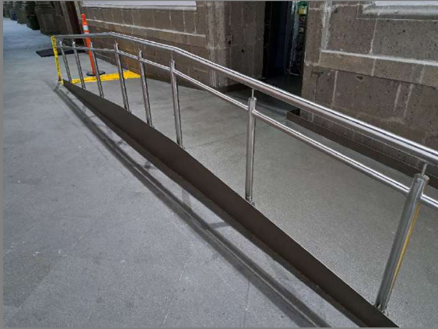
TERMINO DE RAMPA 1ER NIVEL
