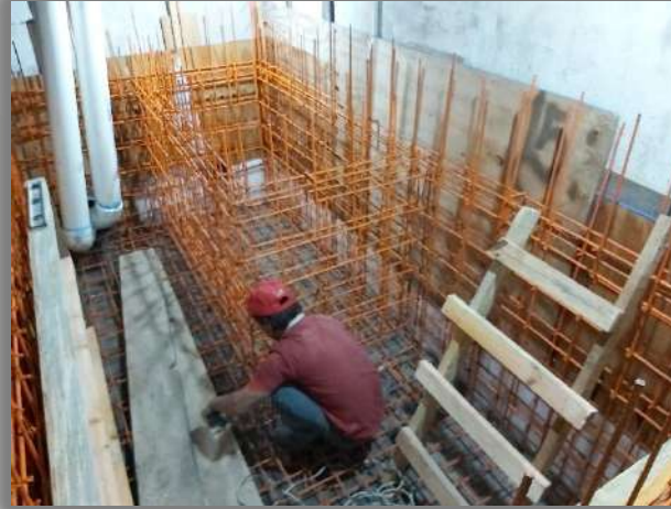
HABILITADO Y ARMADO DE CÁRCAMO
