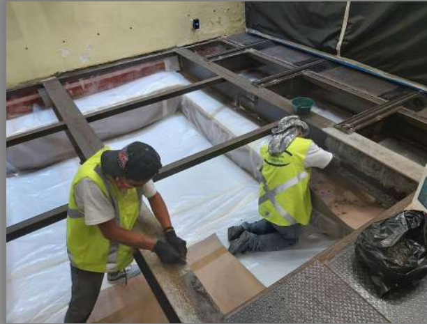
LIBERACION PINTURA ESTRUCTURA METALICA
