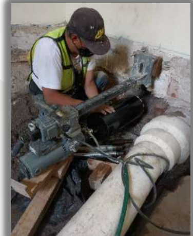
PERFORACIÓN DE BARRENO DE 8" EN MJURO A 1.80 MTS DE LONGITUD
