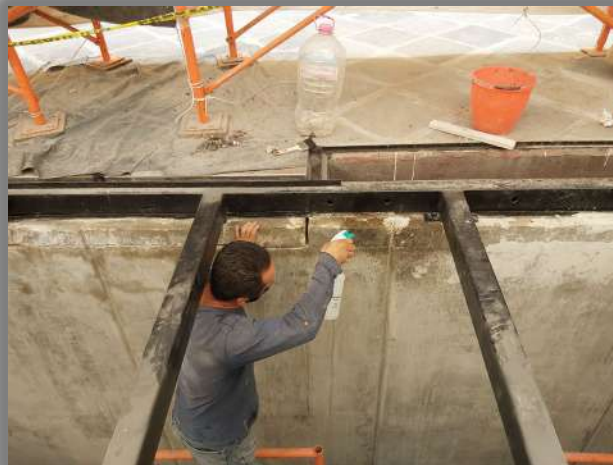
ELIMINACION DE SALES Y LIMPIEZA PROFUNDA
