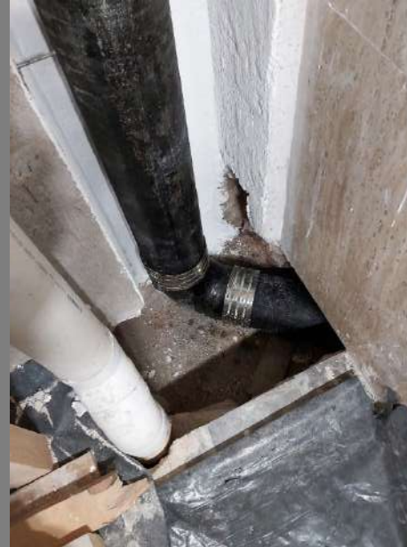
FABRICACION DE TRINCHERA Y REINTEGRACION DE TUBERIA DE FOFO
