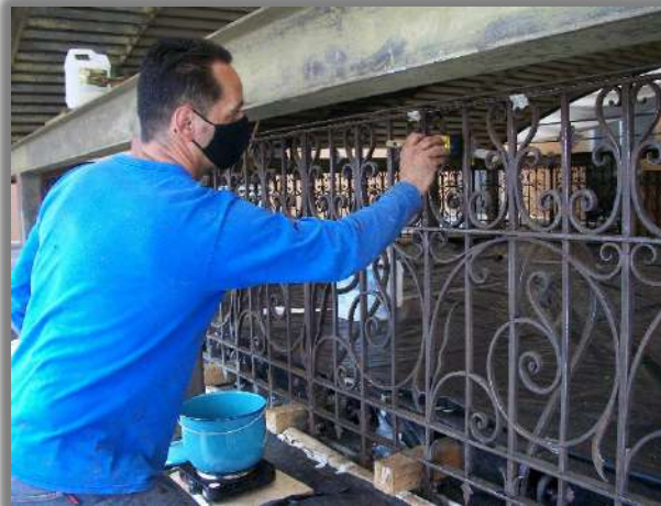
RETIRO DE ACABADO Y APLICACIÓN DE PASIVADO
