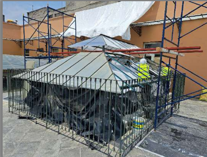
LIBERACION DE PLACAS DE POLICARBONATO Y LIMPIEZA DE ESTRUCTURA
