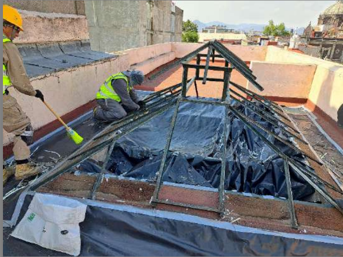
LIBERACION DE PLACAS DE POLICARBONATO Y LIMPIEZA DE ESTRUCTURA
