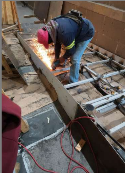
HABILITADO Y ARMADO DE ALFARDA CON PLACA DE ACERO
