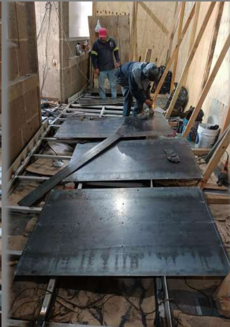
HABILITADO Y ARMADO DE PISO DE RAMPA CON PLACA DE ACERO
