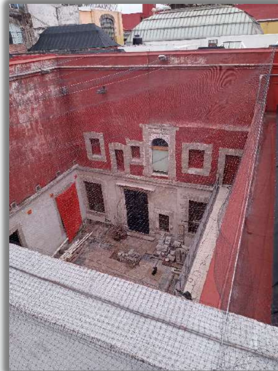
COLOCACION DE MALLA ANTI AVES EN PATIO ORIENTE
