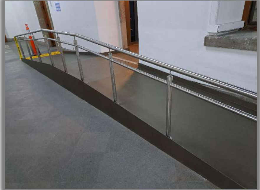
TERMINO DE RAMPA 2DO NIVEL
