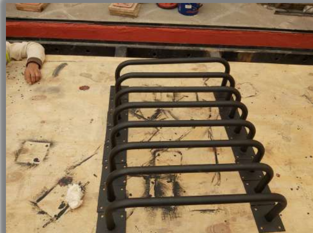
FABRICACION ESCALERA MARINA
