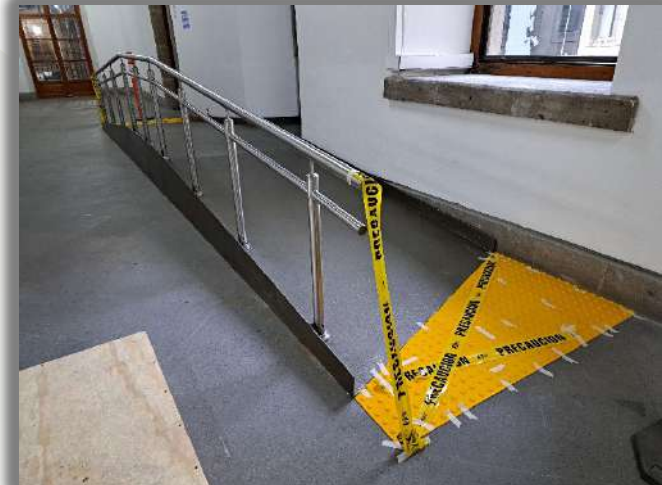
APLICACIÓN DE COLOR EPÓXICO Y COLOCACION DE PISO PODOTACTIL
