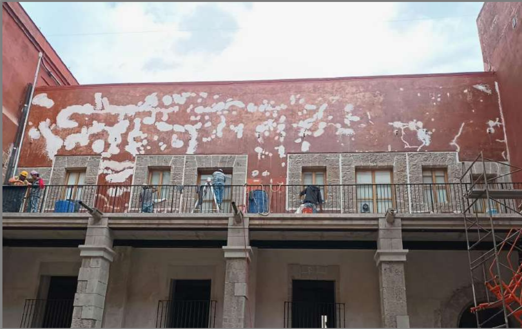
CONSOLIDACION DE GRIETAS Y LIMPIEZA A ENMARCAMIENTO DE CANTERA EN FACHADA NORTE DEL PATIO ORIENTE
