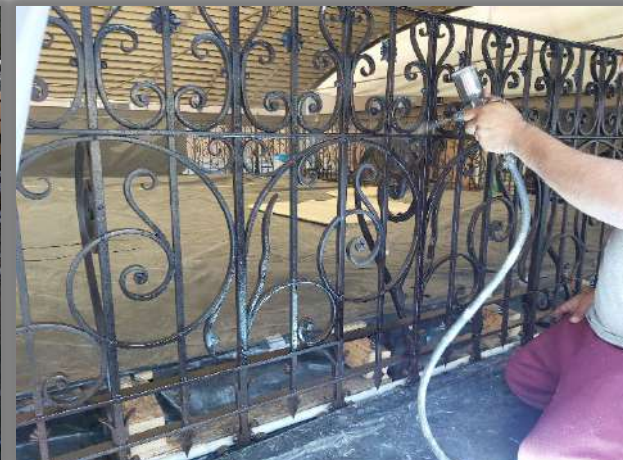
APLICACIÓN DE ACABADO BARNIZ NERVION
