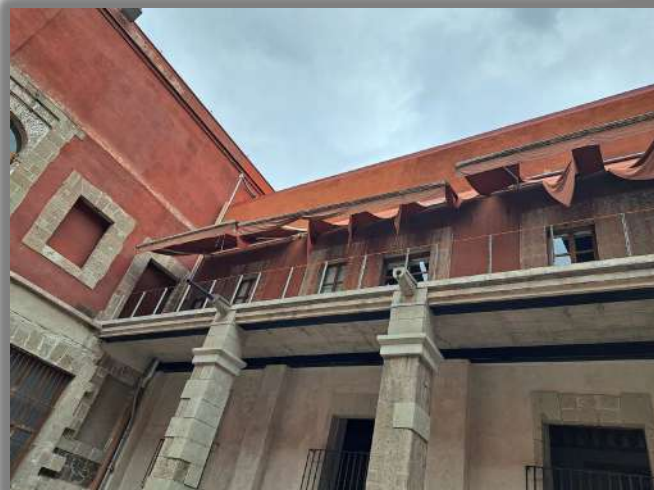
FACHADA PATIO ORIENTE ESTADO ORIGINAL
