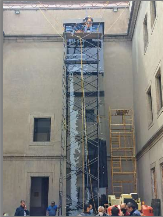
COLOCACION DE LUMINARIAS EN TECHUMBRE DE CUBO DE ELEVADOR
