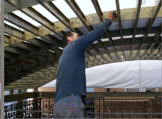
RETIRO DE PINTURA Y LIMPIEZA DE ESTRUCTURA DE DOMO
