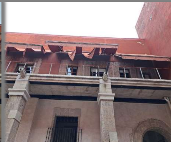
FACHADA PATIO ORIENTE ESTADO ORIGINAL
