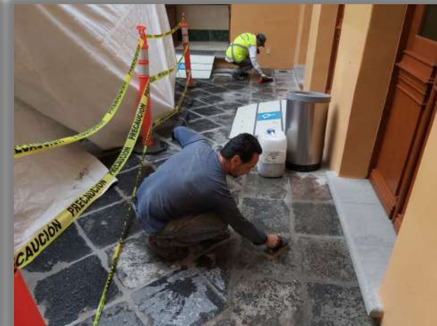
LIMPIEZA PROFUNDA A RECINTO Y APLICACIÓN DE HIDROREPEL
